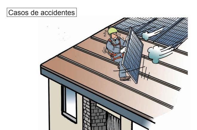
Mientras trabajaba en el montaje de paneles de energía solar en solitario, cuando llevaba un panel sobre el techo, fue empujado por un fuerte viento y voló junto con el panel.
