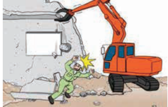
Desplomes de material en los trabajos de demolición
