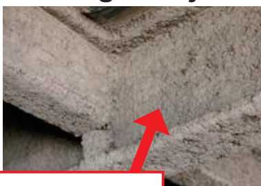
Lapisan tahan api rangka baja
