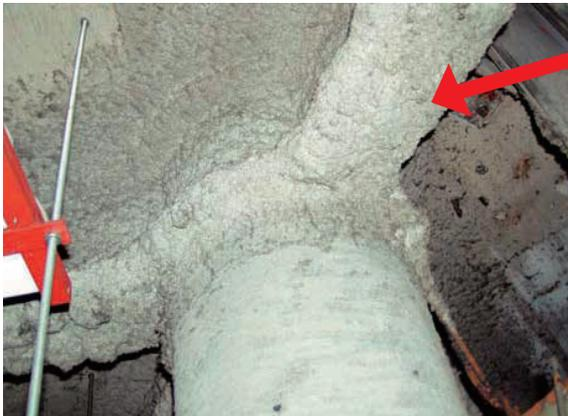
Utilizado para resistência ao fogo de estruturas de aço
