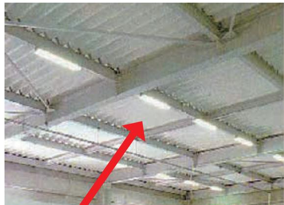
Utilizado para prevenção de condensação e isolamento térmico no telhado (semelhante a feltro)
