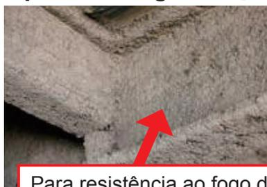
Para resistência ao fogo de estruturas de aço
