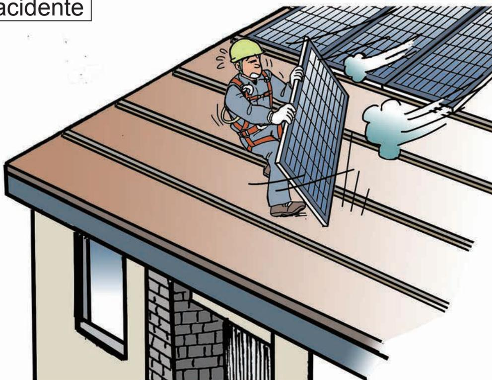
Quando o trabalhador estava instalando painéis solares fotovoltaicos sozinho, no momento que estava carregando o painel no telhado, foi atingido por uma ventania e quase foi arremessado junto com esse painel.
